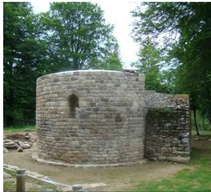
Église de St Pierre de l'Espinouse, en cours de restauration
